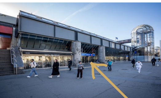
Hlavní vchod – severní část
